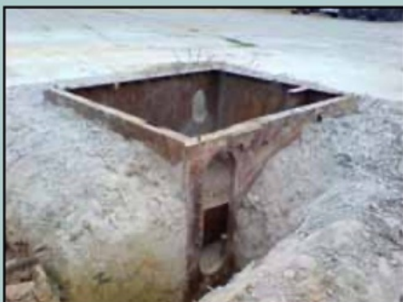
Panther toren I, staalsokkel voor snelle installatie.
